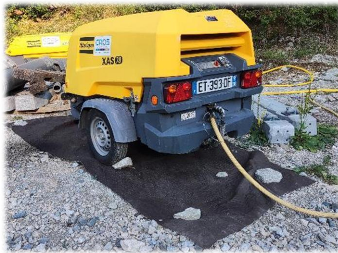
Figure 114 : Engin de chantier disposé sur un géotextile absorbant (P. Salen, Ecosphère)
