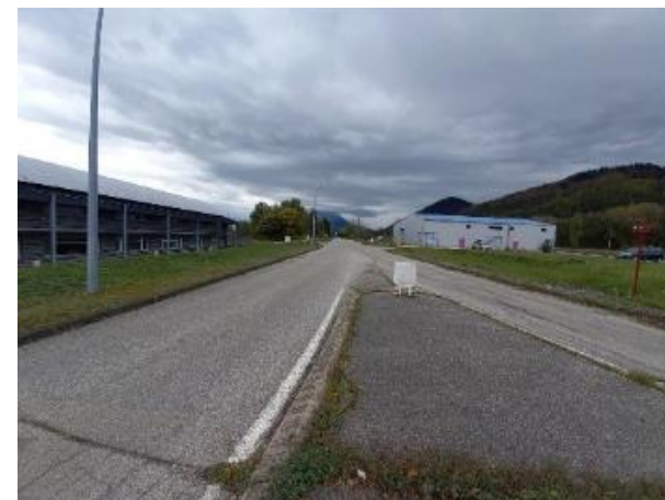
3 : Rue des Houillères traversant la zone d'étude nord/sud
