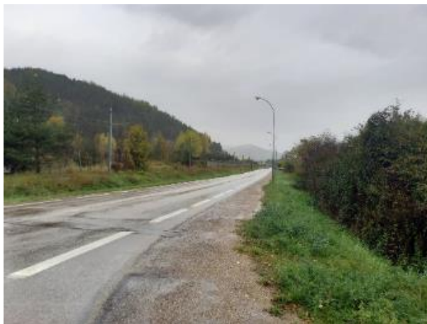
26 : Route du Villaret délimitant l'ouest du secteur
