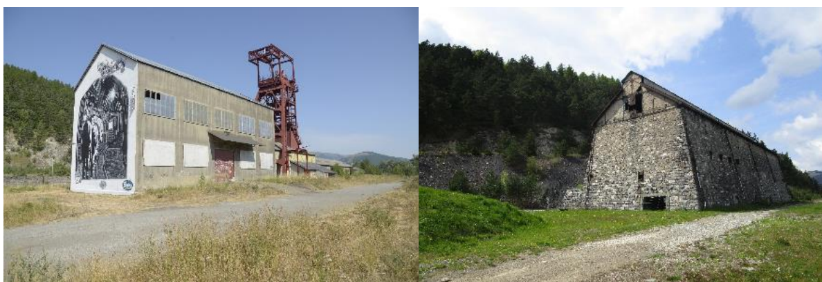
Figure 101 : Le Chevalement côté Sud Est et le bâtiment à charbon depuis son côté Sud-Est (photo commune de Susville)
