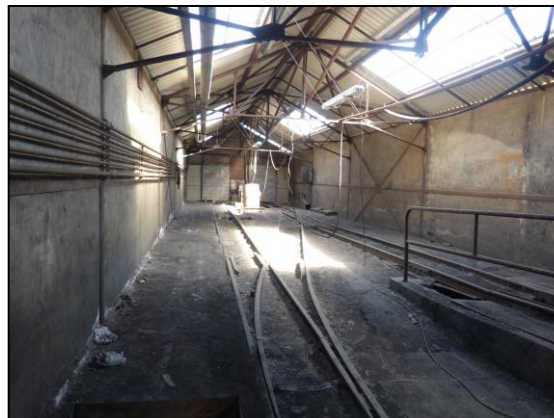
Intérieur du bâtiment nord du Puits du Villaret (Sur site, C. Sequin, Ecosphère)
